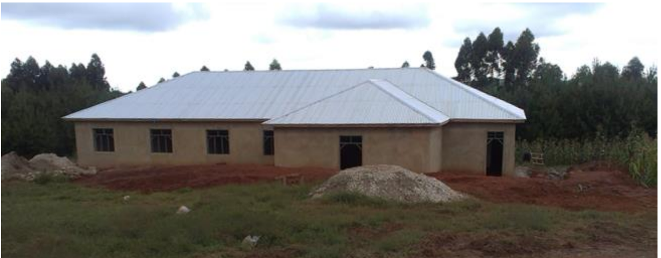
2 Beispiel für das Jungs Hostel: Bau eines der beiden Mädchen Hostels kurz vor der Fertigstellung
